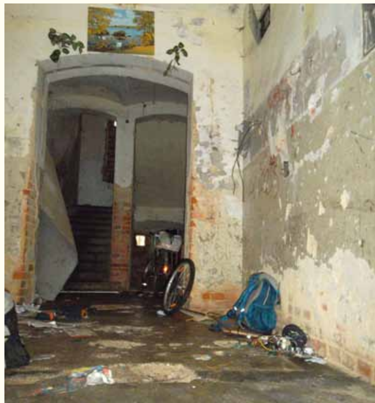
Treppenhaus | Bild © KARO e.V. 2012
